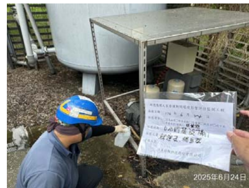
(中水貯留設施)
